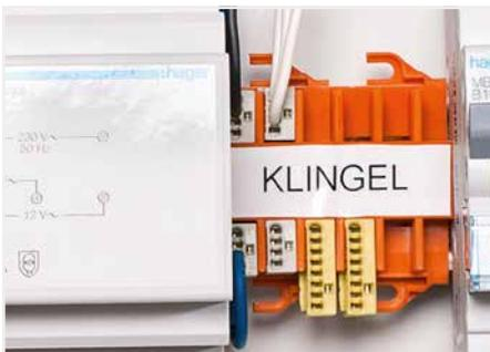
Anwendung für eine Hausklingelanlage – Befestigung auf Tragschiene 35
