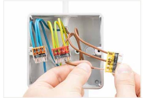
Anschließen: Abisolierten eindrätigen oder mehrdrätigen Leiter bis zum Anschlag einstecken.
