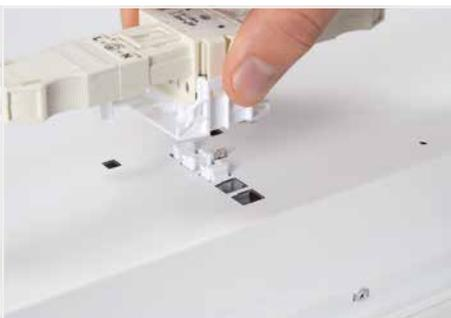
Steckverbinder in den beiden quadratischen Aussparungen positionieren.
